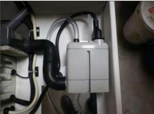
Anschlussbereich unten, mit Elektro-Anschlusskasten.
