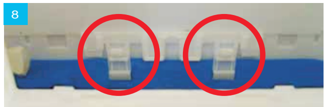
Der Inliner hinter der Befestigungsleiste einschieben
