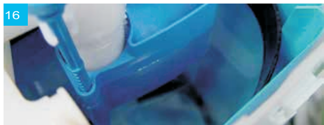
Wasserstand auf Unterkante Spannring
